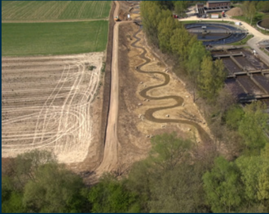
Renaturierung des Haarbachs mit neuem Gerinne
